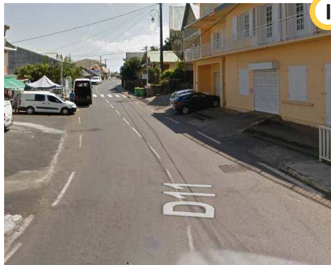
Photographie (I) : À Piton, trottoir entrecoupé par des accès pour véhicules obligeant le piéton à se déporter sur la route.
