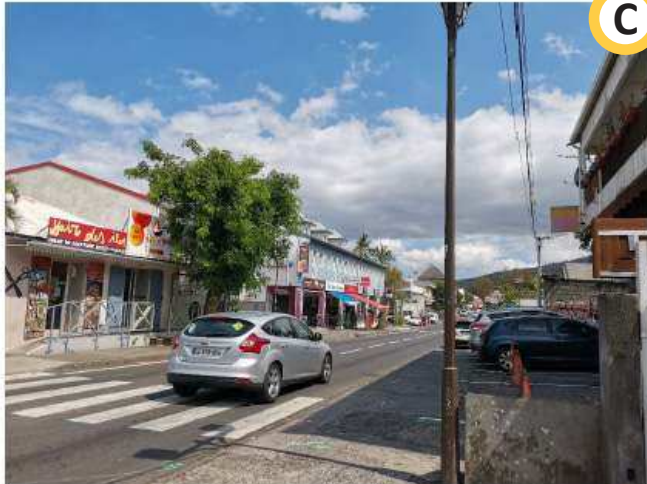
Espaces de stationnement qui rompt et gêne le cheminement normal et conduit ou oblige le piéton à se déplacer en situation de risque.
