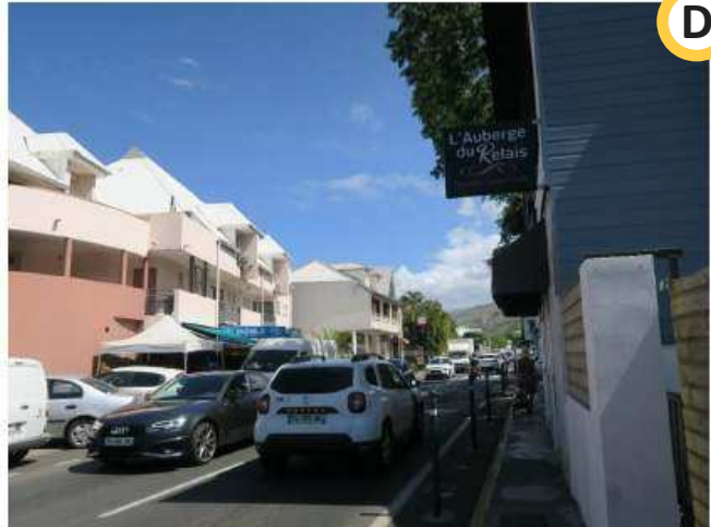
Trottoir étroit qui ne permet pas le croisement des piétons mais aussi de passages de PMR et poussettes.
