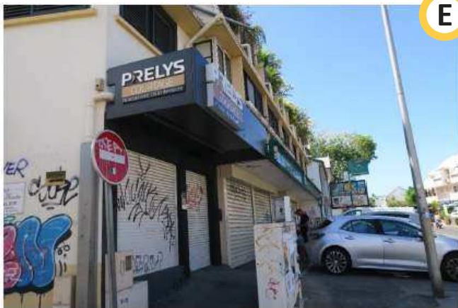
Implantation désordonnées de mobiliers urbains (poteau, boîtier électrique) qui rend difficile la déambulation des piétons sur le trottoir.
