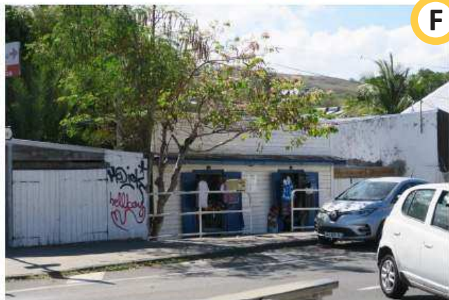
Accès non PMR du commerce situé en dessous du niveau de la route.
