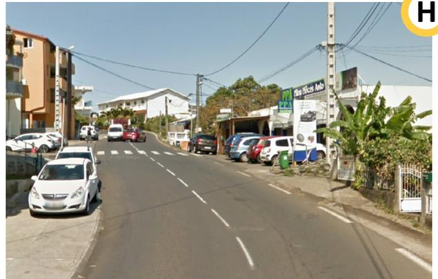
Photographie (H) : À Piton, trottoir présent seulement d'un côté de la route et utilisé par du stationnement illégal obligeant le piéton à se déporter sur la route.
