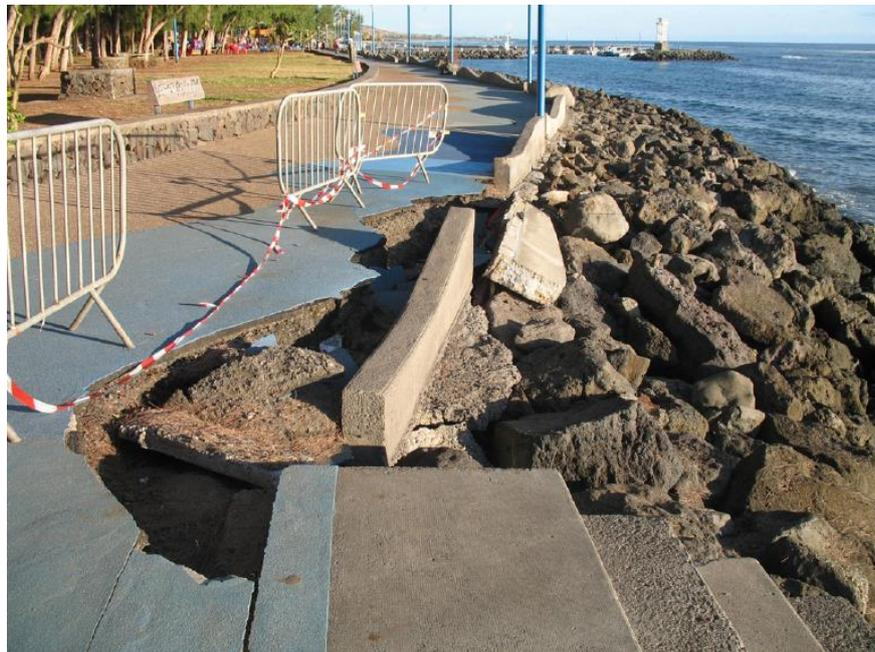
*Figure 28 : Affouillements sous le chemin piétonnier (SOGREAH, 2007)*
