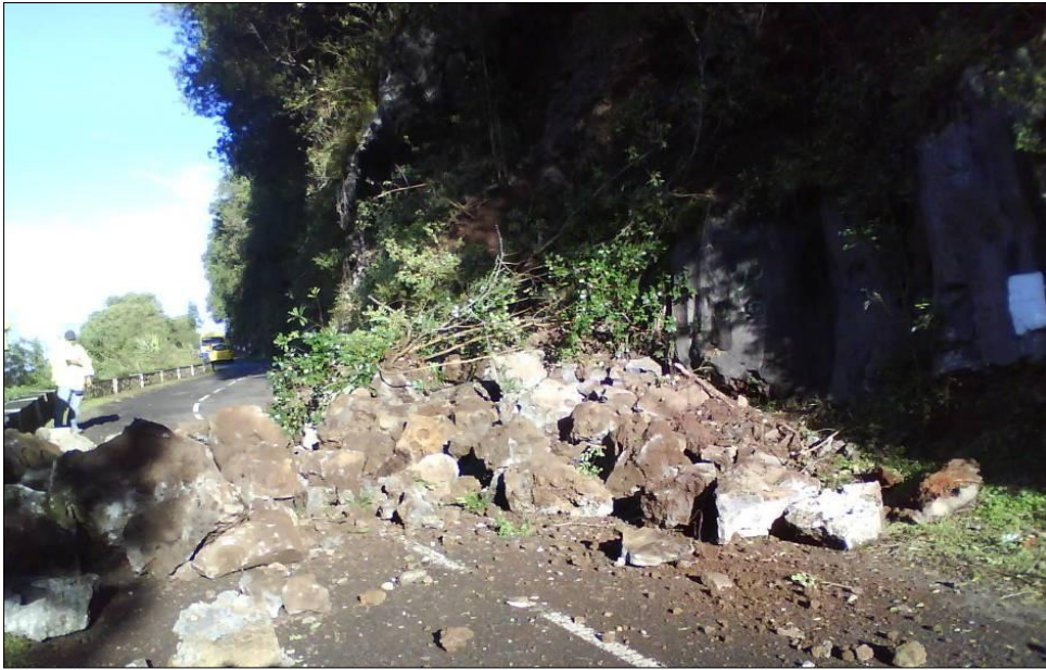
Figure 12 : Eboulement de 20 m 3 sur la RD3 en 2010 à Saint Leu (rapport BRGM RP-58856-FR)
