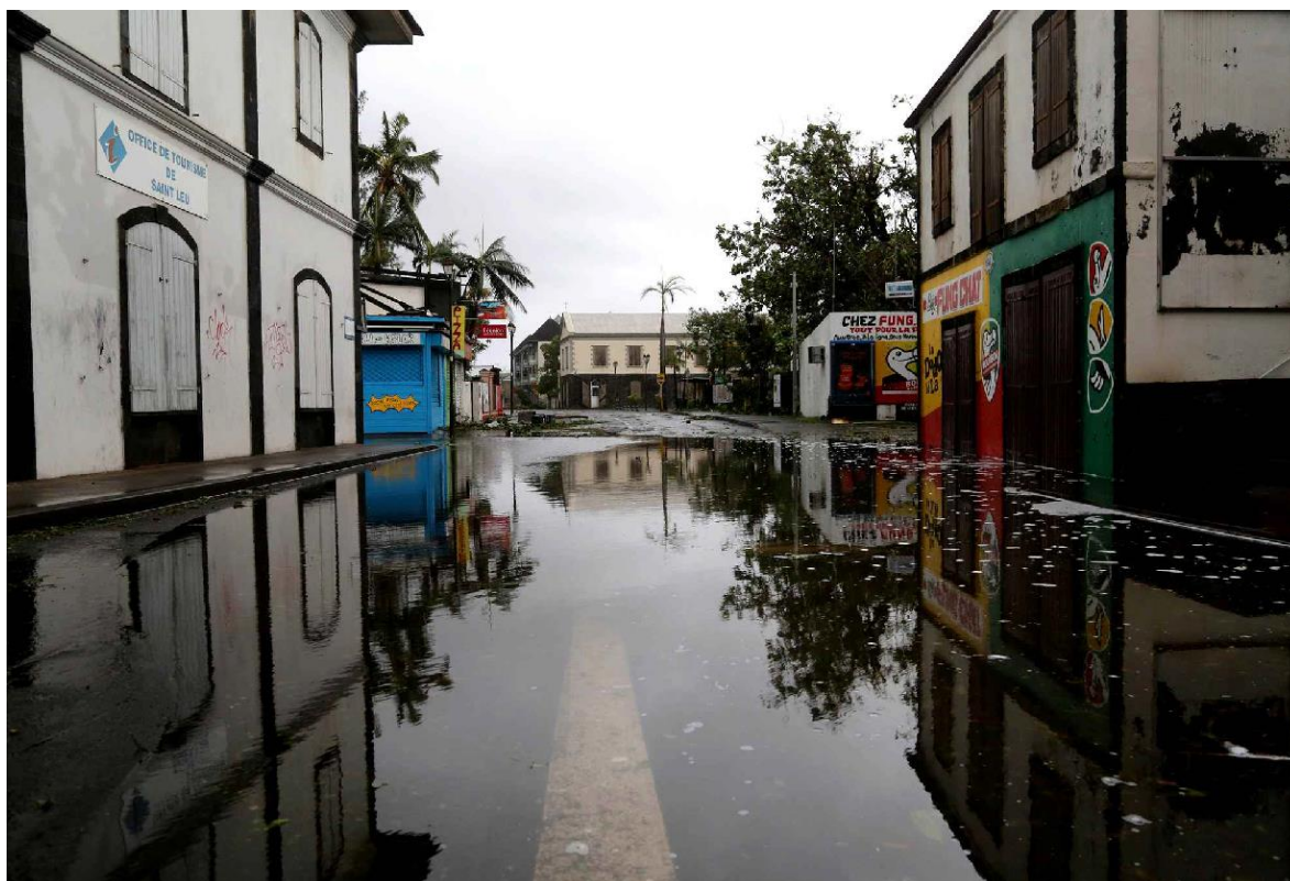
Figure 18 : Inondation du centre-ville de Saint-Leu lors du passage du cyclone Bébisa (janvier 2014)
