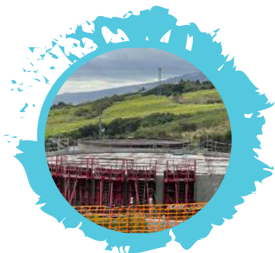
Construction d'une usine de potabilisation à Maduran et de ses réservoirs
