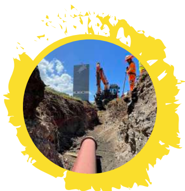
Modernisation du réseau d'eaux usées au centre-ville de Saint-Leu
