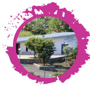
Remise aux normes des deux chapelles ardentes
