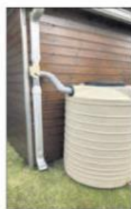
Le collecteur de gouttière anti-moustique est fixé à mi hauteur pour récupérer l'eau de pluie et l'envoyer vers le réservoir.
